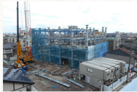
△鉄骨建方工事が進む建設現場
