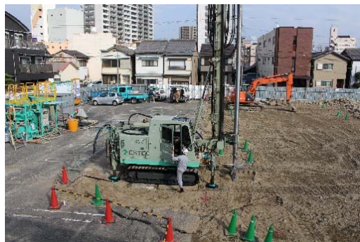
△会館建設工事現場の様子
