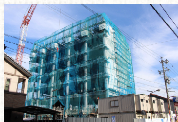
△鉄骨建方工事が完了した新会館建設現場
