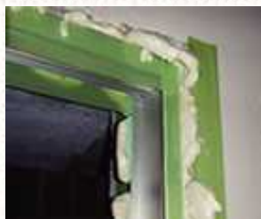
▲仮止めの様子（写真左）と 隙間を完全に充填させた施工例（写真右）
